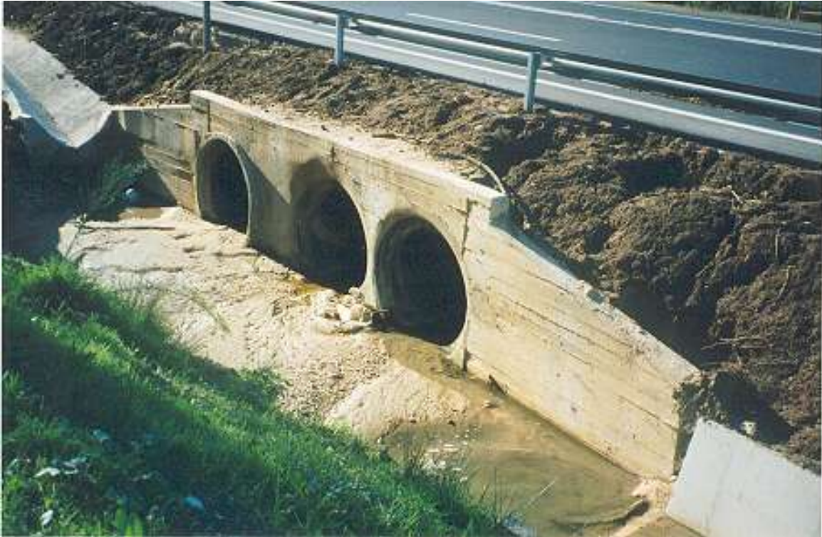
Figura C3 – Aqueduto triplo de secção circular.
