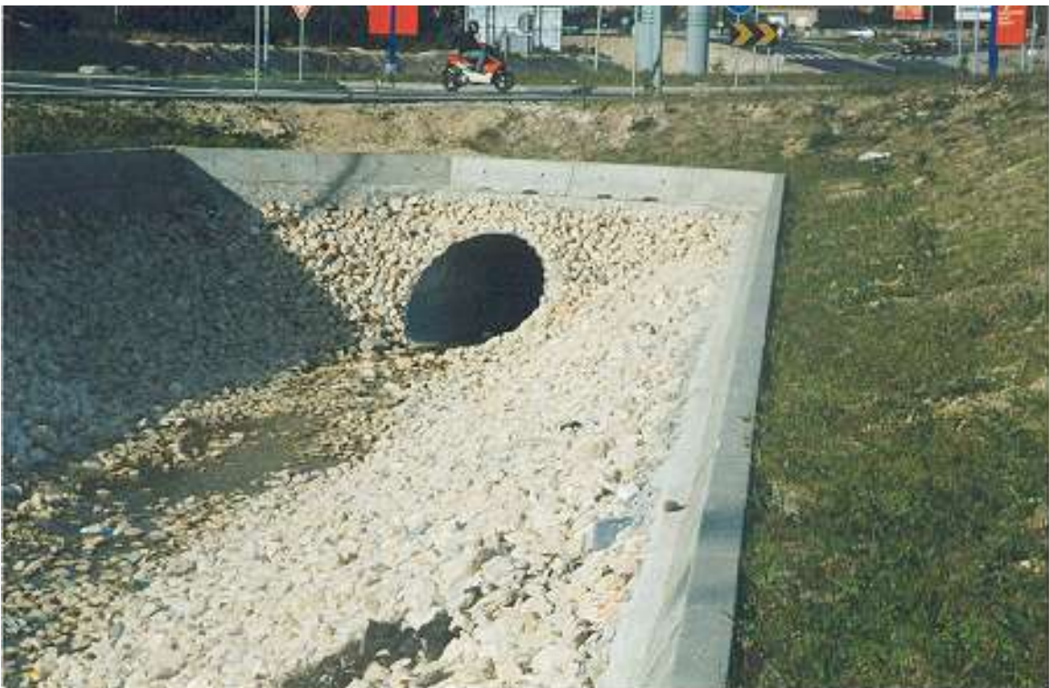
Figura C6 – Aqueduto em tubo metálico corrugado ( corrugated pipes ).
