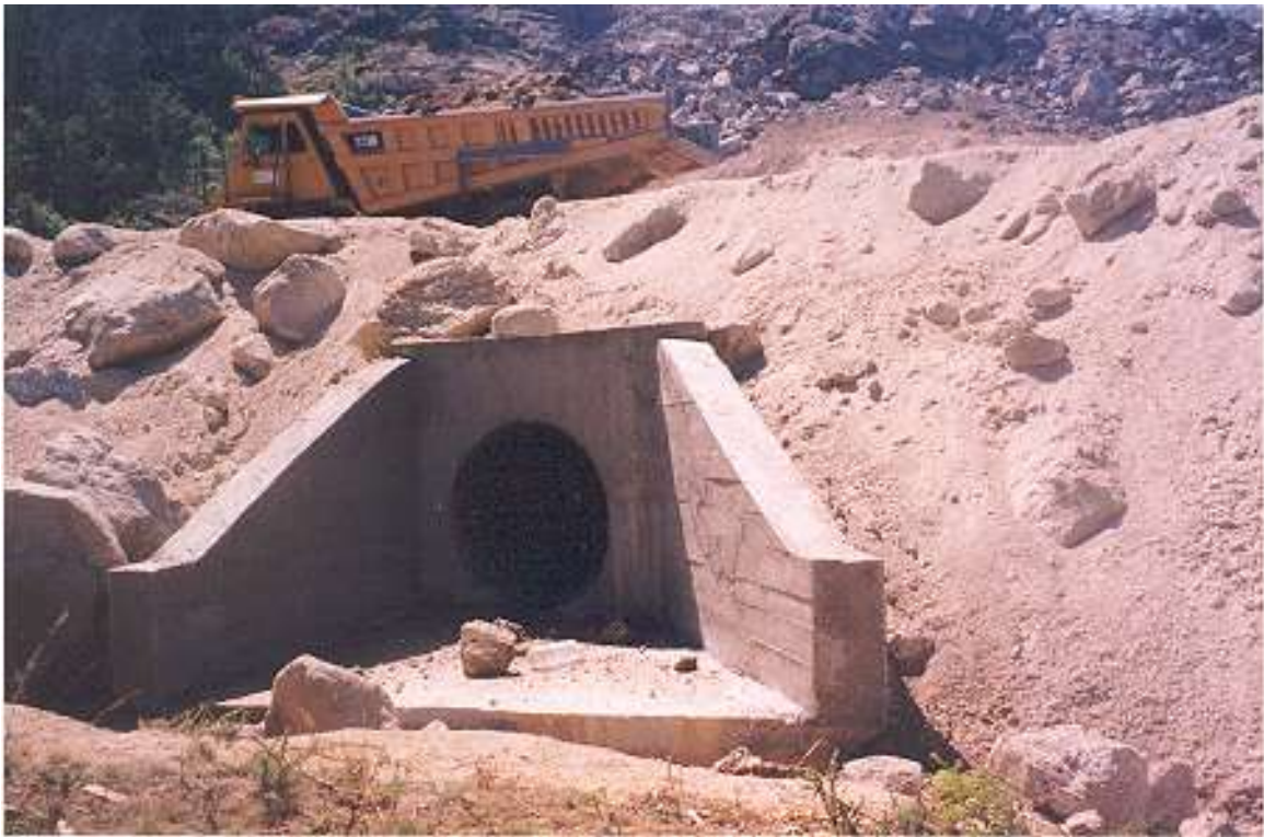
Figura C11 – Estrutura de saída com muros de ala.
