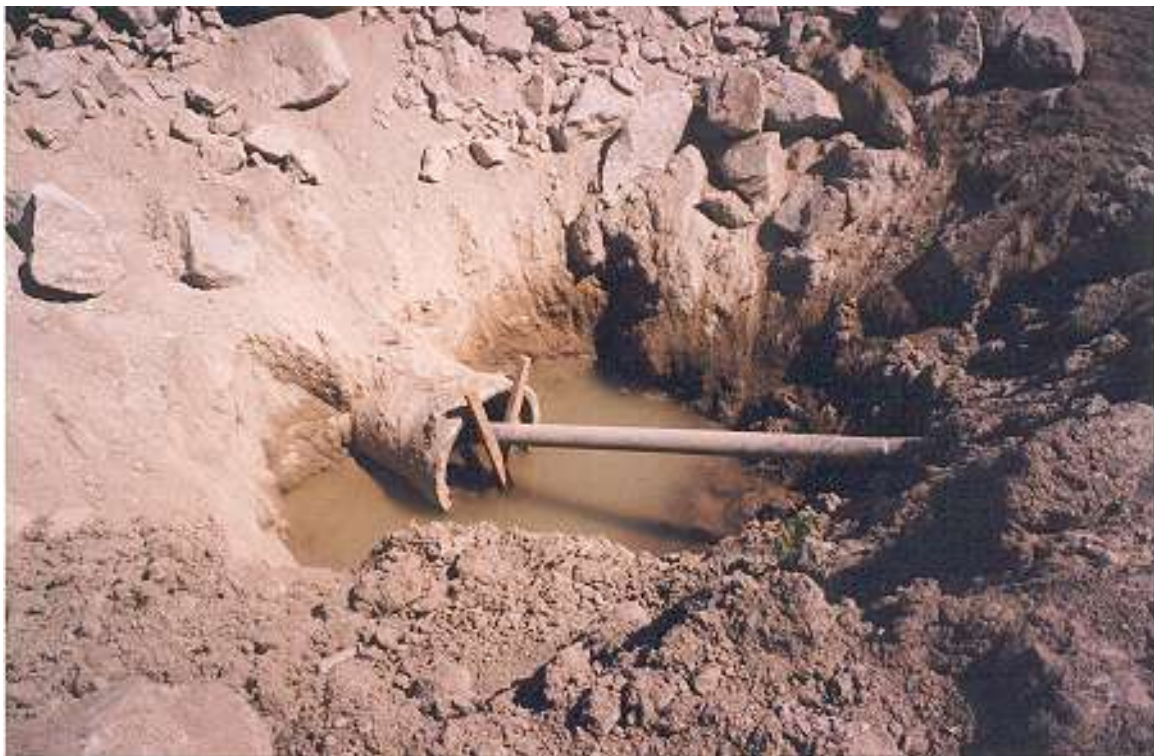
Figura C8 – Construção de aqueduto de secção circular.
