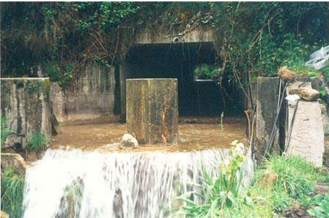
Figura C4 – Aqueduto de secção rectangular.
