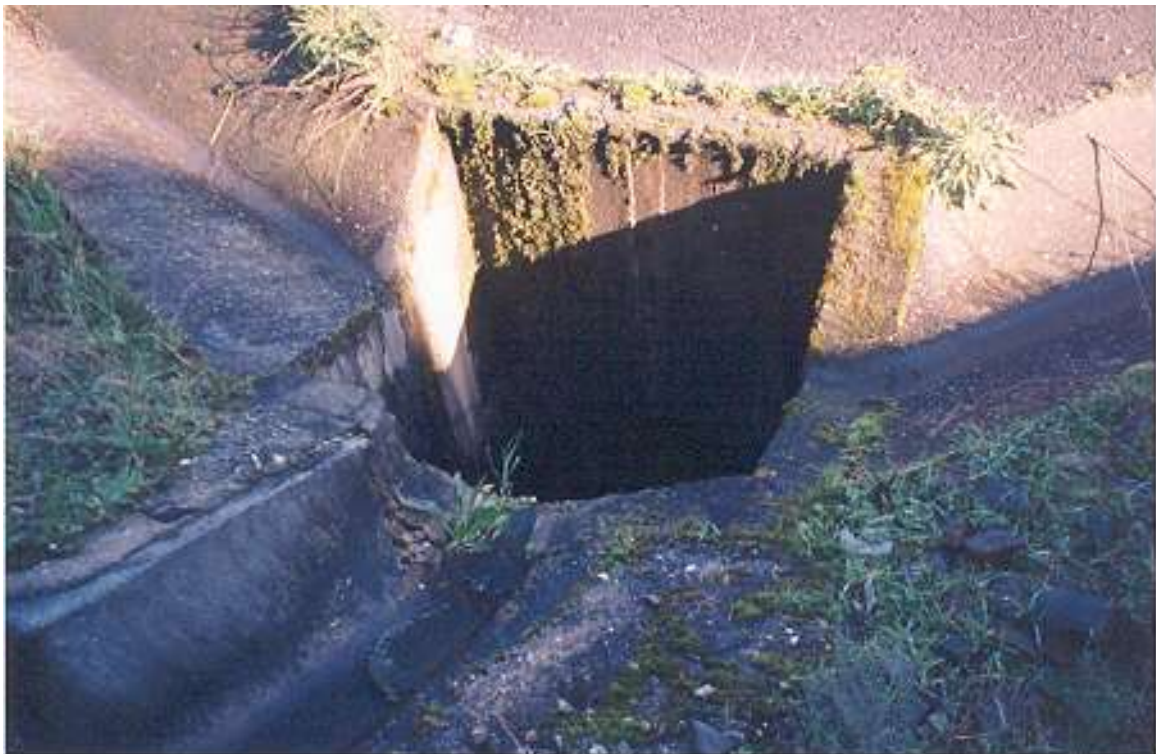
Figura C12 – Estrutura de entrada em recipiente.
