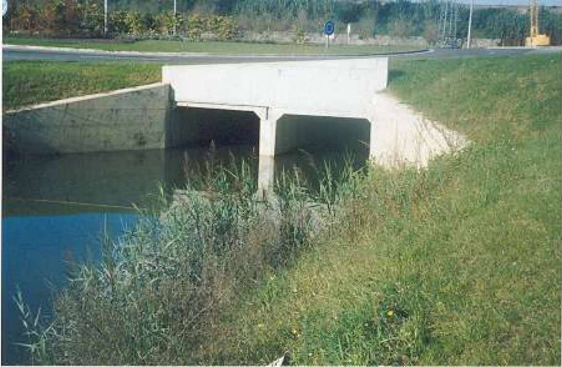
Figura C5 – Aqueduto duplo de secção rectangular.
