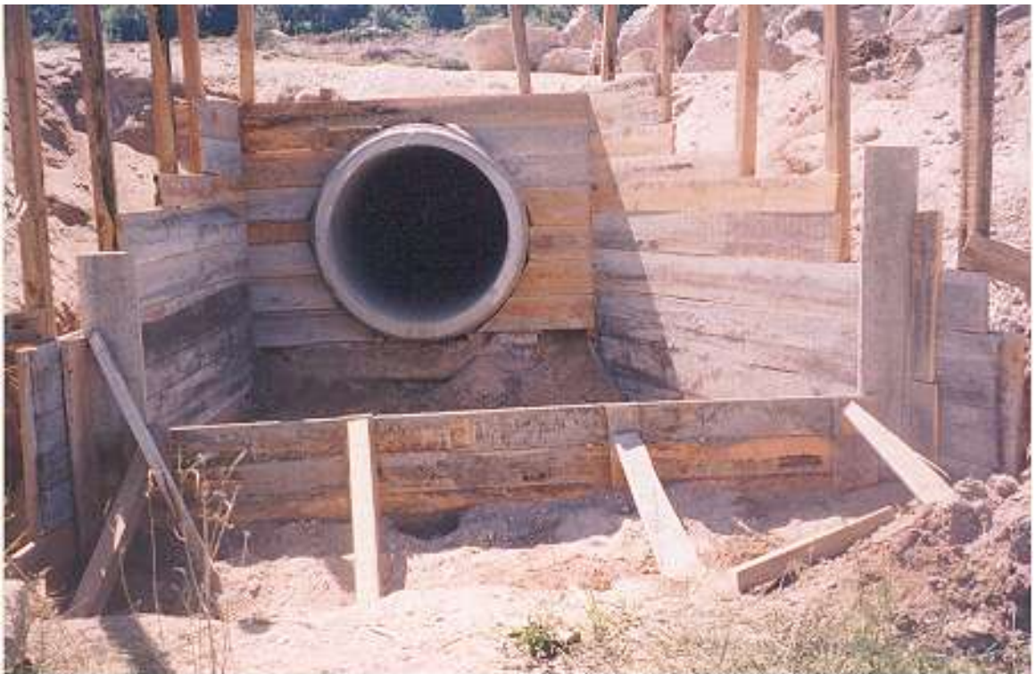
Figura C10 – Cofragem de estrutura de entrada com muros de ala.
