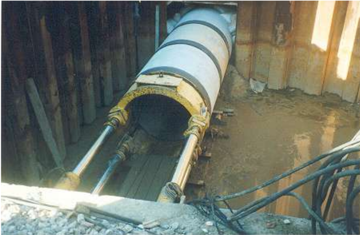
Figura C7 – Execução de um aqueduto de secção circular com macacos hidráulicos.
